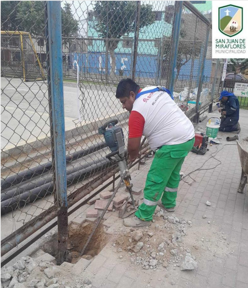
Reparación de parantes de rejas
