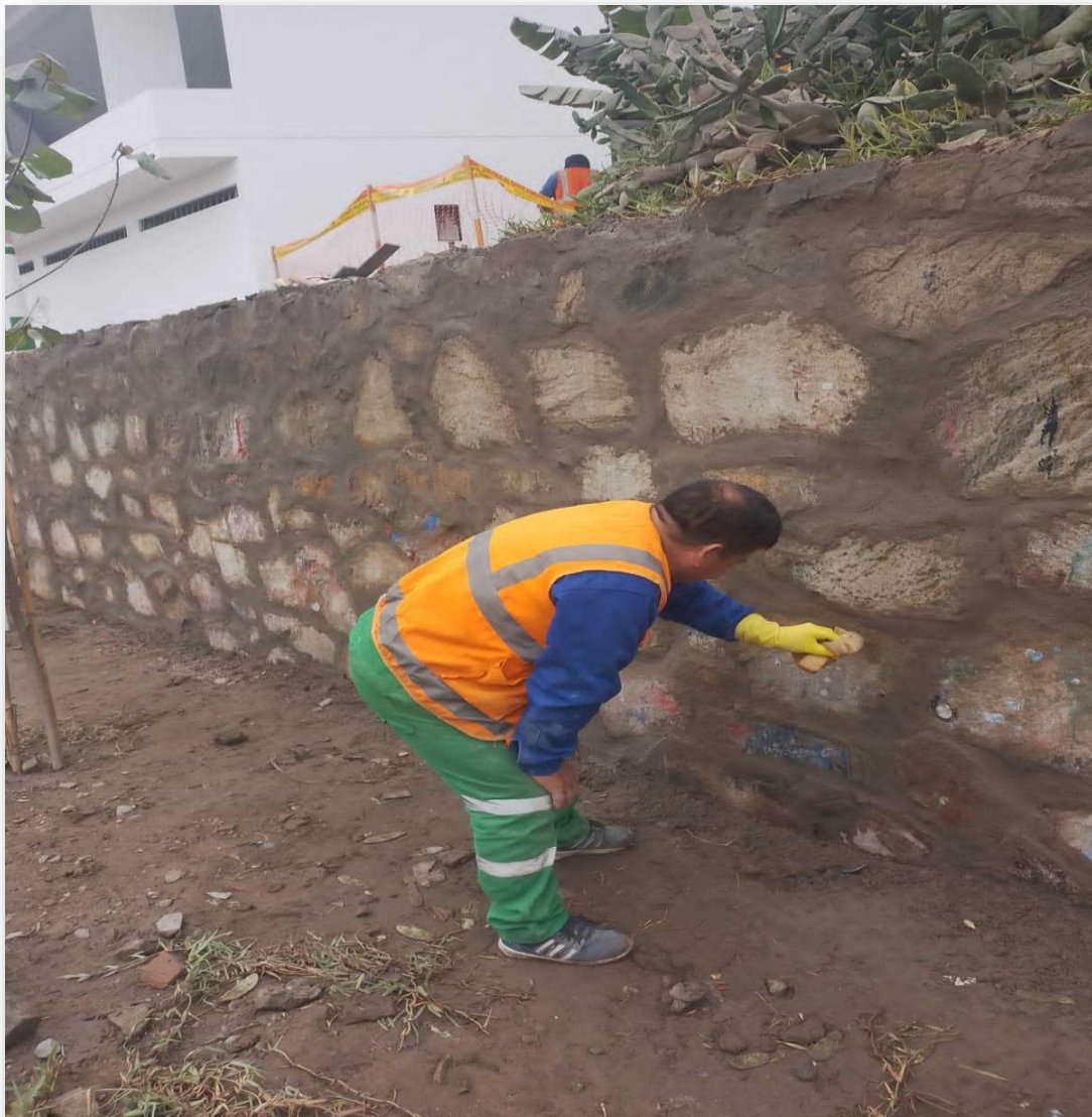
Mantenimiento de muros contención
